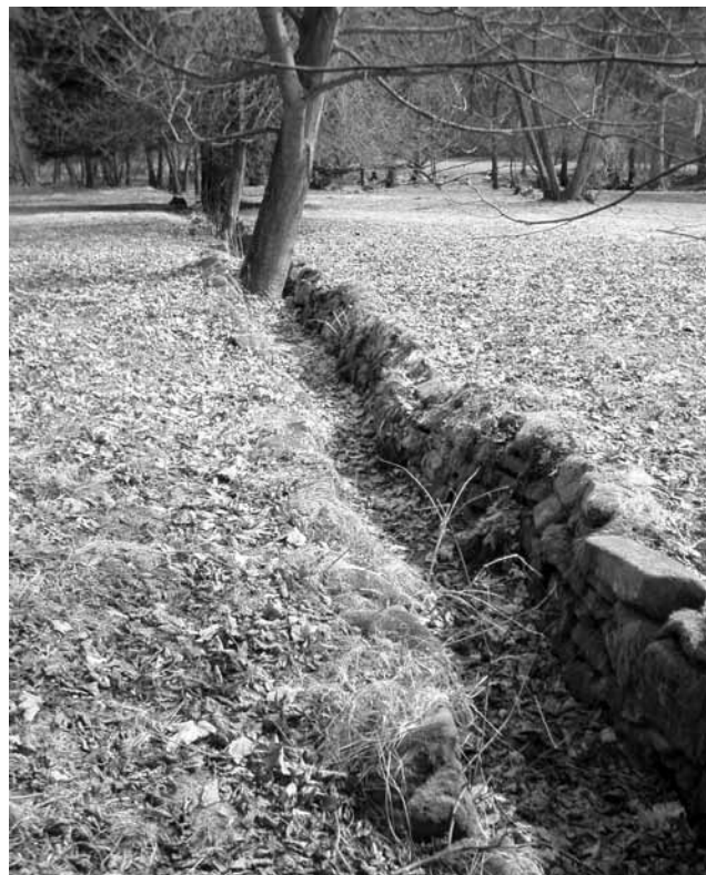
Odlehčovací kanál opevněný kamenem.
