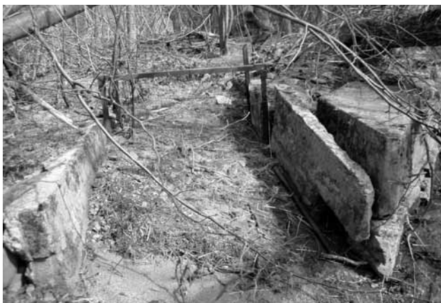
Stavidlo dolního přírodního (plavebního) kanálu (pohled od Odry).
