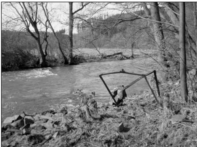
Stavidlo horního přívodního kanálu u řeky Odry (pohled k Odře; v místě, kde se u protějšího břehu čeří voda, je zřejmá poloha přívodního prahu ve dně řeky, který naváděl vodu do kanálu).
