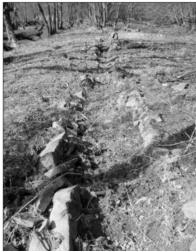
Trasu horního přívodního kanálu prozrazují vyčnívající kameny původního opevnění břehů.
