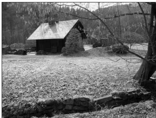
Srub Nečasových na základech bývalé stodoly patřící ke klokočovské pile, v popředí odlehčovací kanál.
